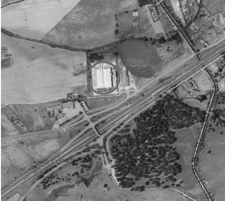
Fig. 3. Emplazamiento IBERHIPAC, S.A.
